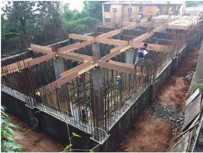
Bouw drinkwater tank
